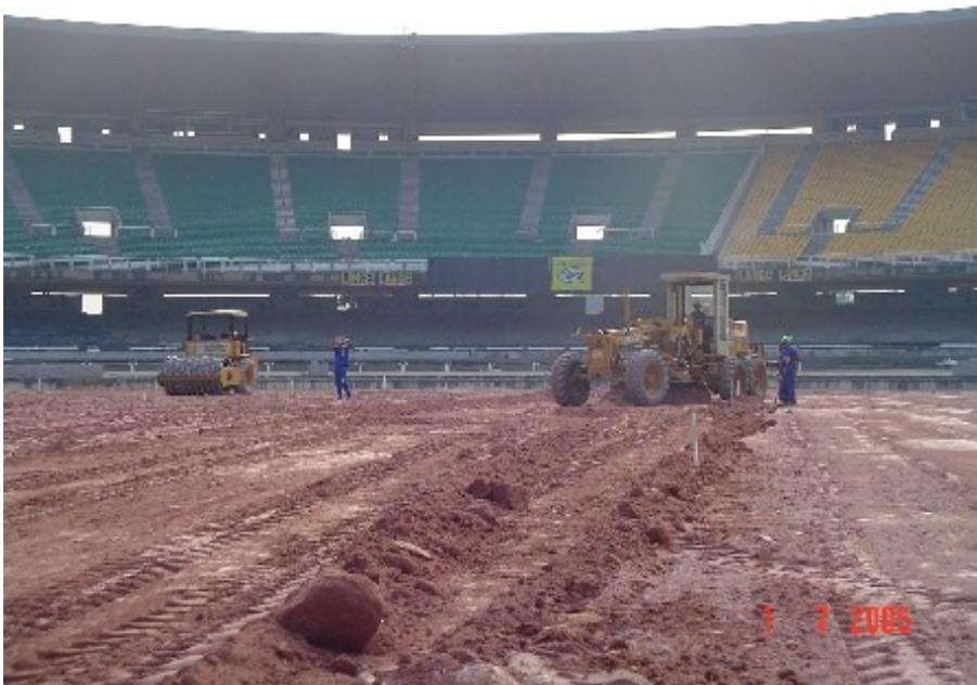
Preparação do terreno para a execução da drenagem.
