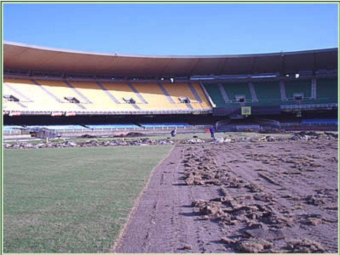
Detalhe do início da obra.
