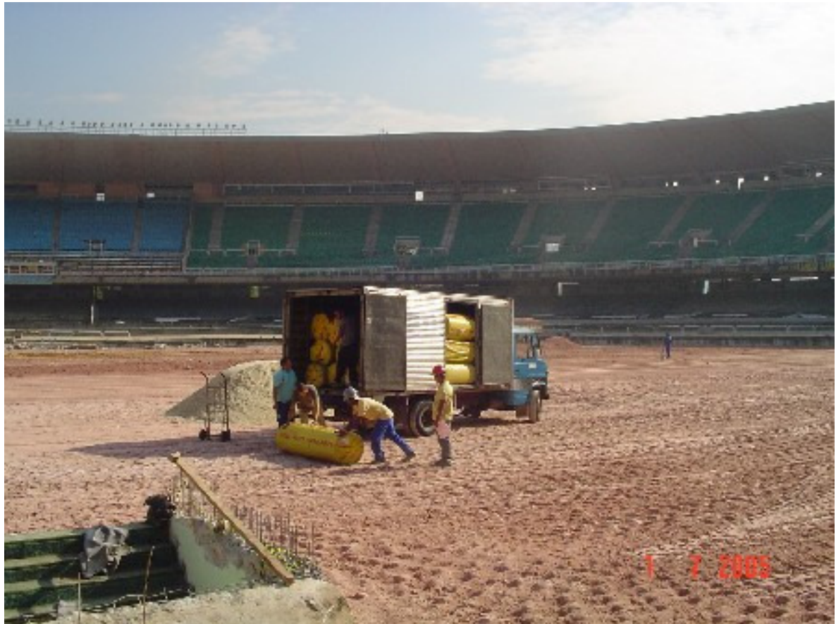
Descarregamento das bobinas de Manta Geotêxtil Bidim RT-10.
