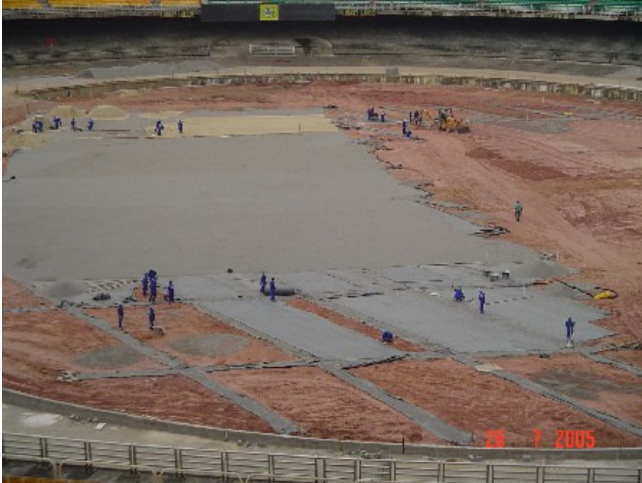
Vista geral do campo com a execução da camada de Manta Geotêxtil Bidim RT-10.
