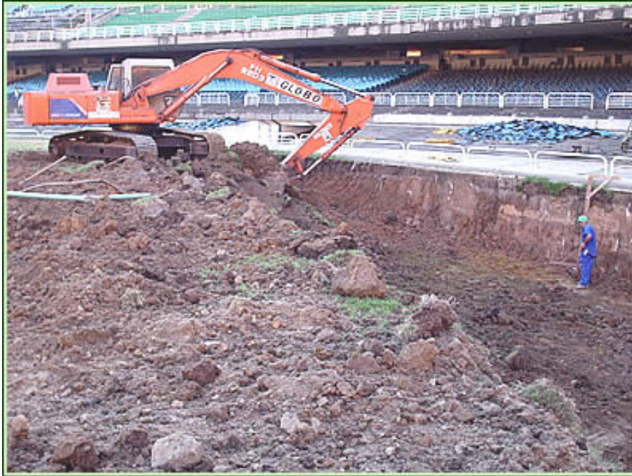
Detalhe do rebaixamento do campo.
