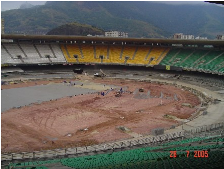
Vista geral do campo.
