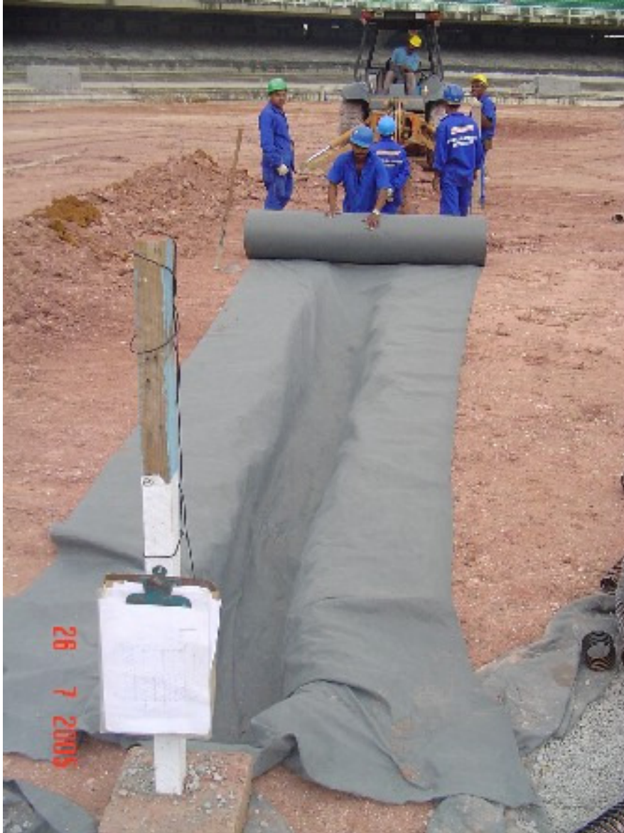
Detalhe da colocação da Manta Geotêxtil Bidim RT-10.
