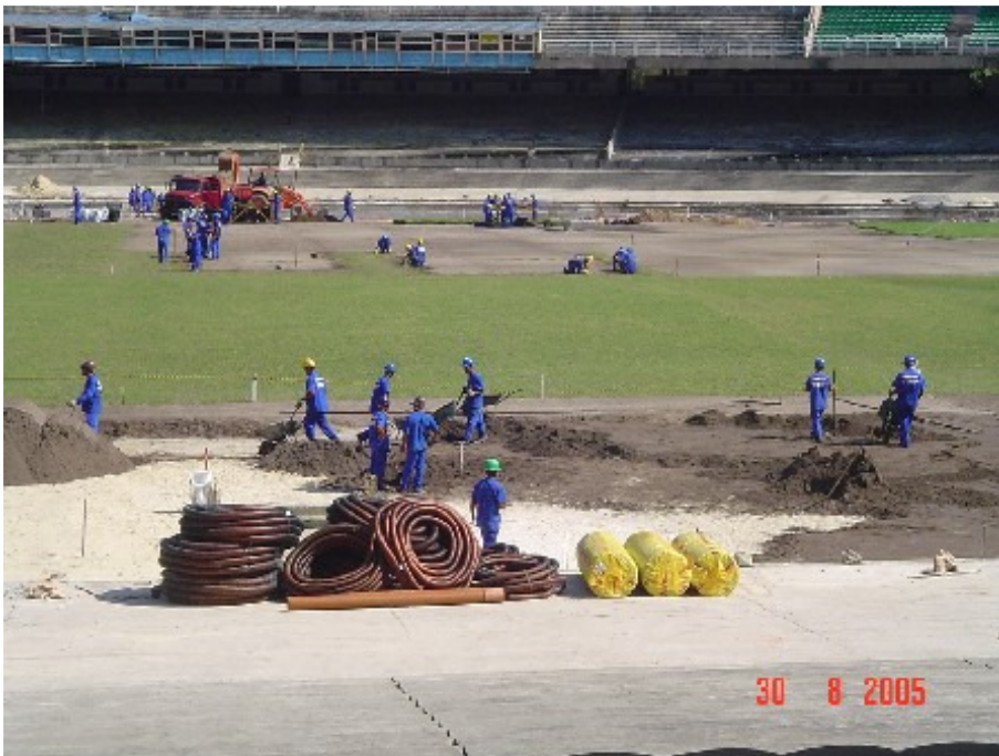
Vista geral do campo em fase de finalização.
