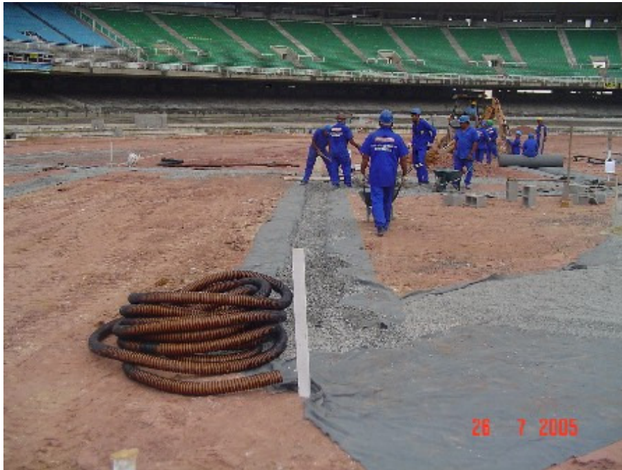
Detalhe da trincheira drenante.
