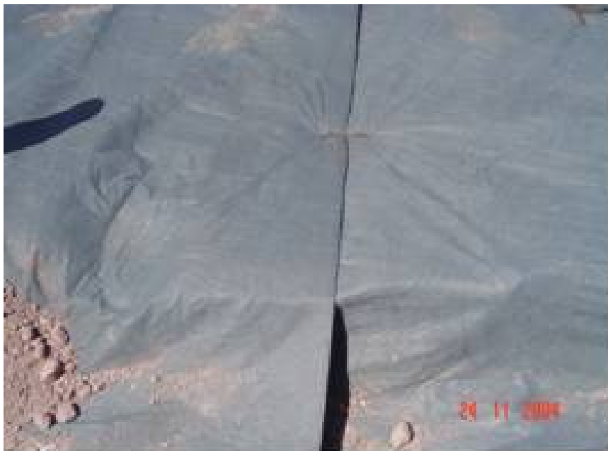
Detalhe de fixação da Manta Geotêxtil Bidim RT-21 com grampo metálico.
