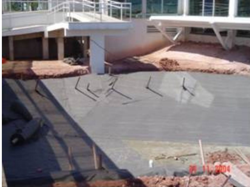
Manta Geotêxtil Bidim RT-21 já instalado, notando-se as tubulações de água.
