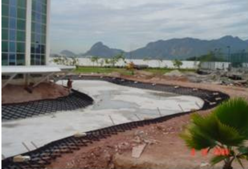
Vista do Geoweb sendo instalado sobre os taludes.
