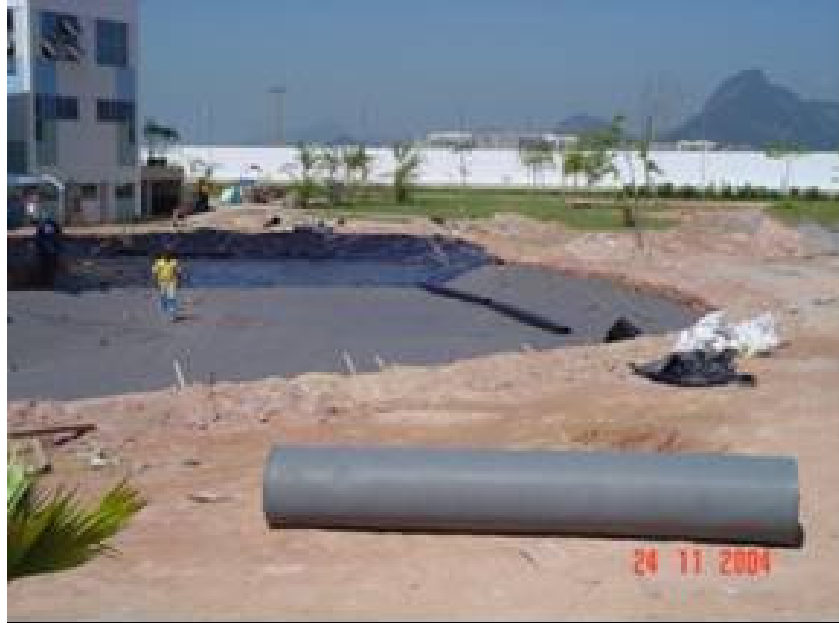
Vista geral com Manta Geotêxtil Bidim RT-21 sendo instalado. Ao fundo a instalação da geomembrana.
