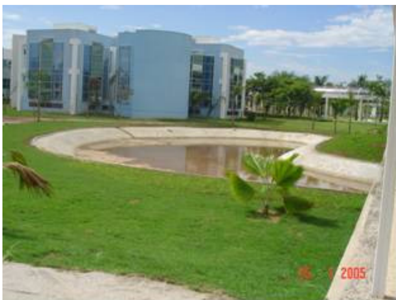
Vista geral da obra concluída, notando-se o edifício do SESC ao lado.
