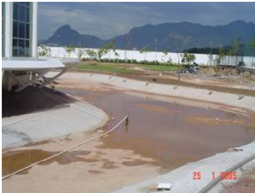
Vista dos taludes laterais já concretado.
