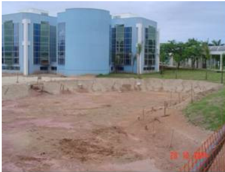
Vista da escavação do lago.
