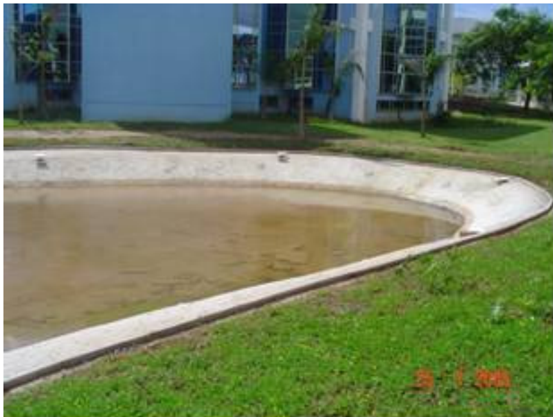
Vista geral da obra concluída, notando-se o edifício do SESC ao lado.
