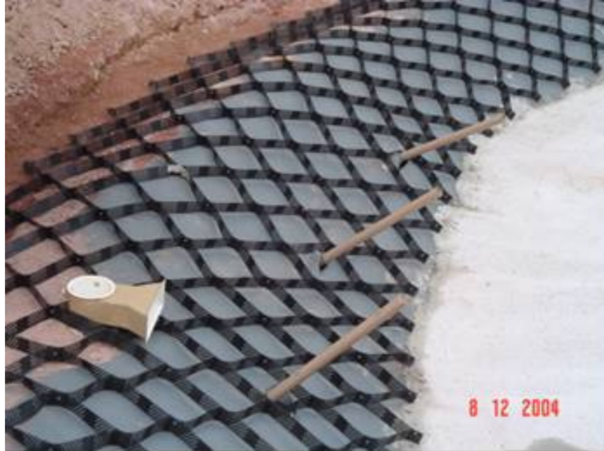
Detalhe do Geoweb nos taludes laterais,
