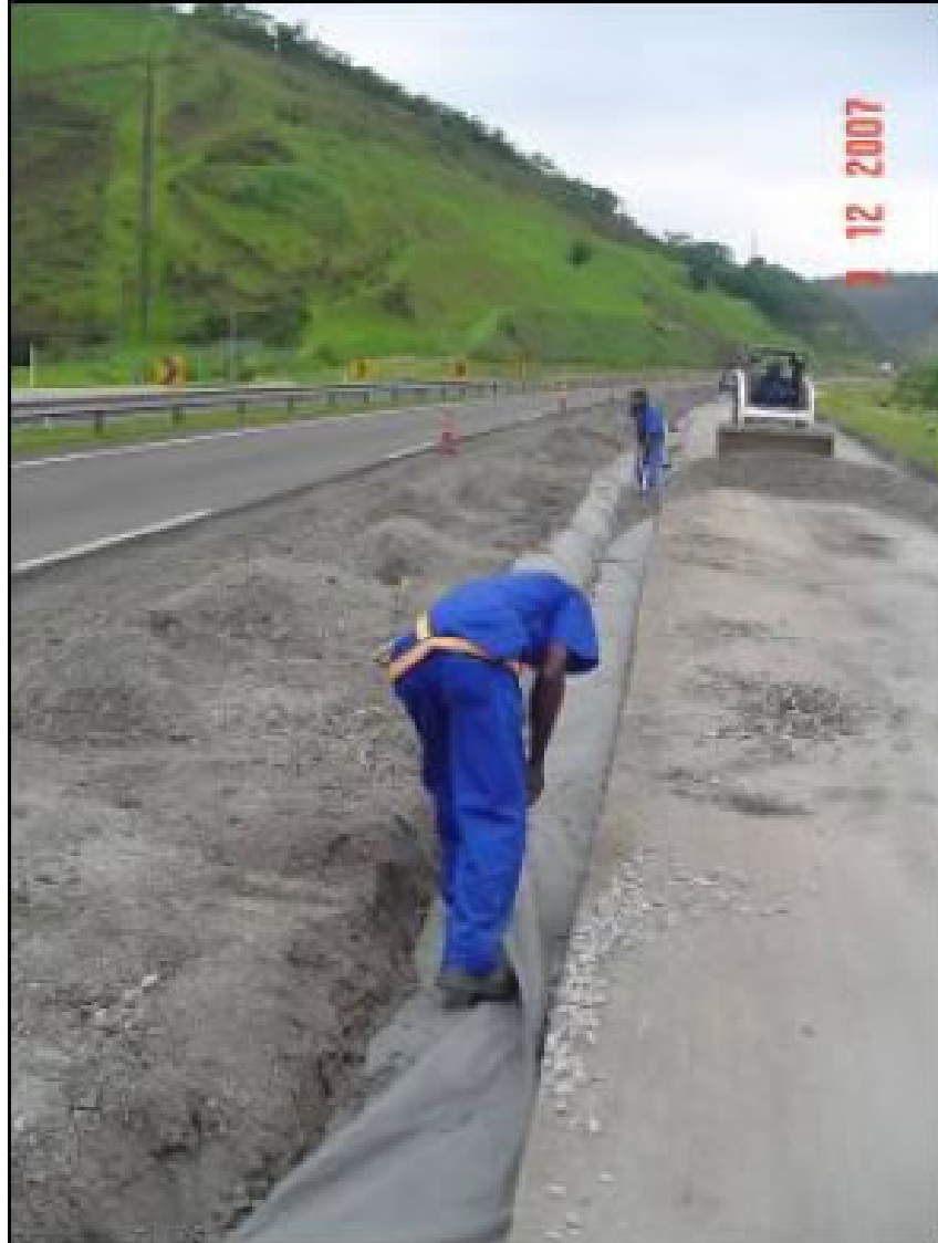
Figura 8: Envolvimento da trincheira drenante Manta Geotêtil Bidim RT-10.
