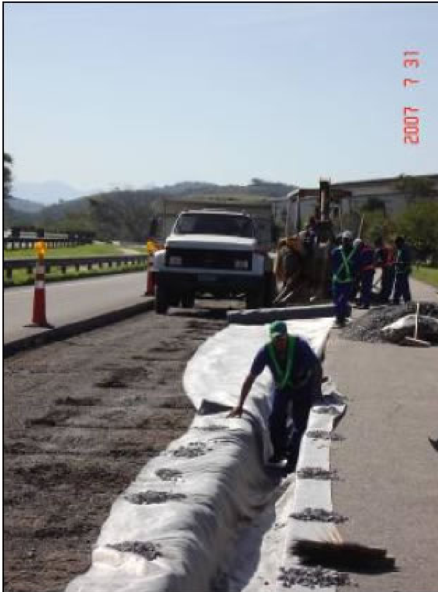
Figura 5: Vala de drenagem com o lançamento da Manta Geotêxtil Bidim RT-10.
