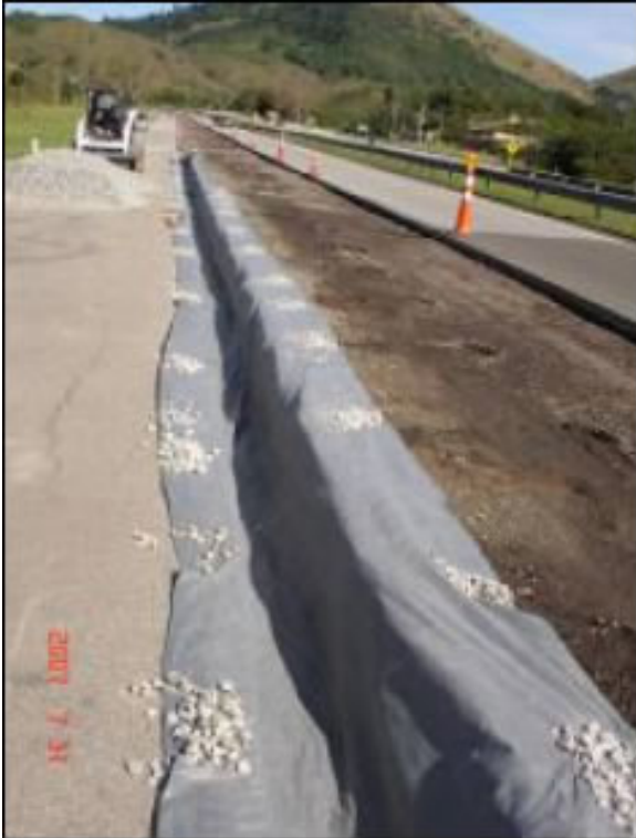
Figura 6: Detalhe da vala de drenagem com o lançamento da Manta Geotêxtil Bidim RT-10.
