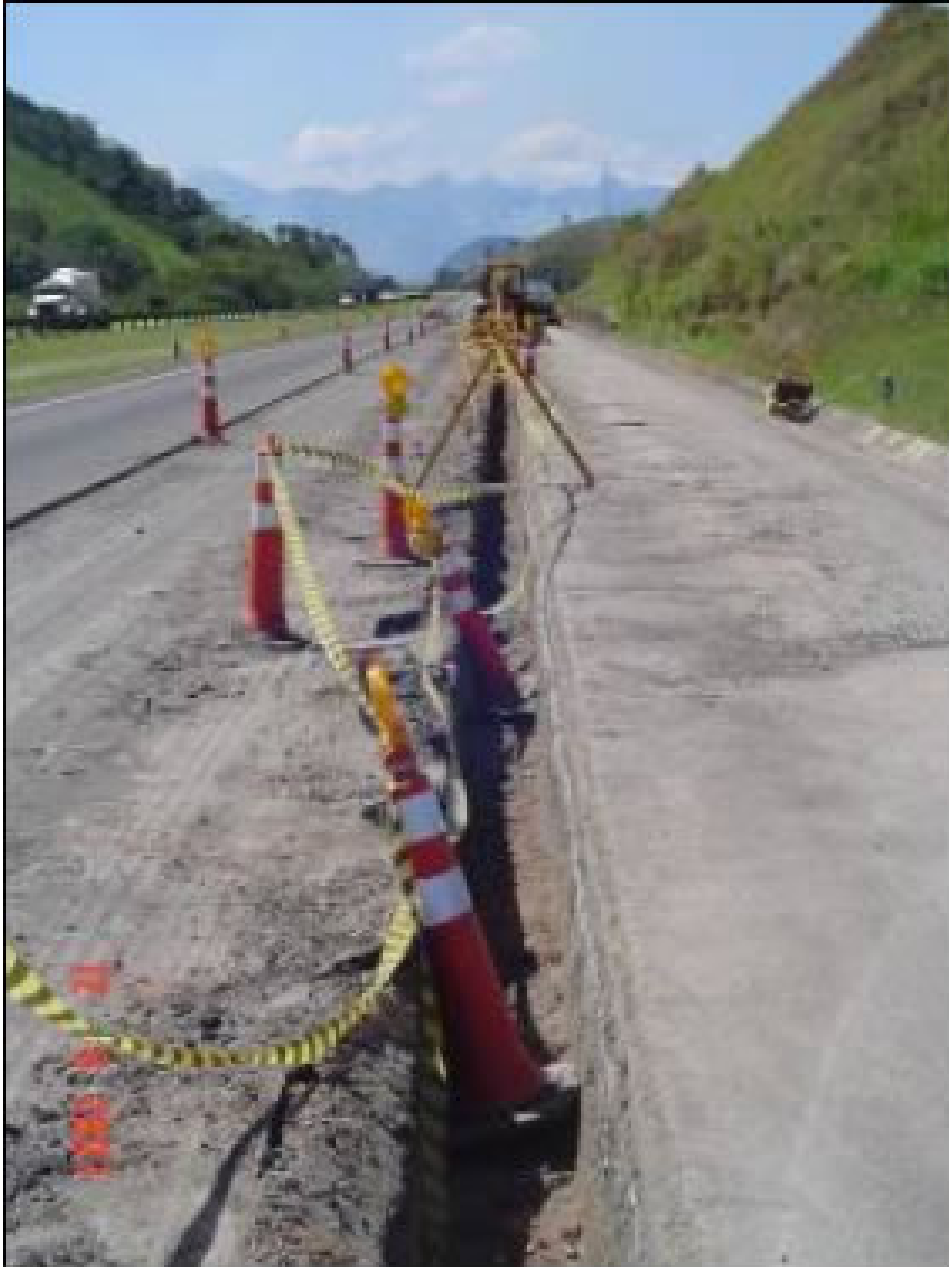
Figura 2: Vista da trincheira longitudinal ao longo da pista
