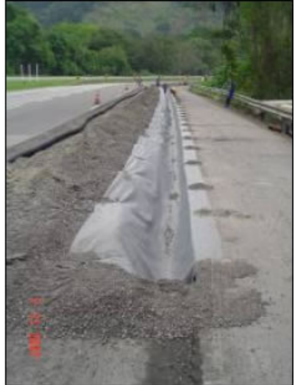
Figura 6: Detalhe da vala de drenagem com o lançamento da Manta Geotêxtil Bidim RT-10.
