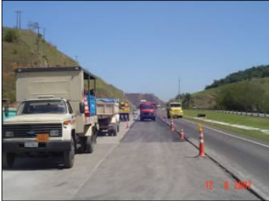
Figura 9: Início da colocação da nova base de CBUQ.
