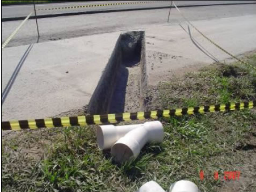
Figura 3: Detalhe da trincheira transversal ao lado da pista no acostamento
