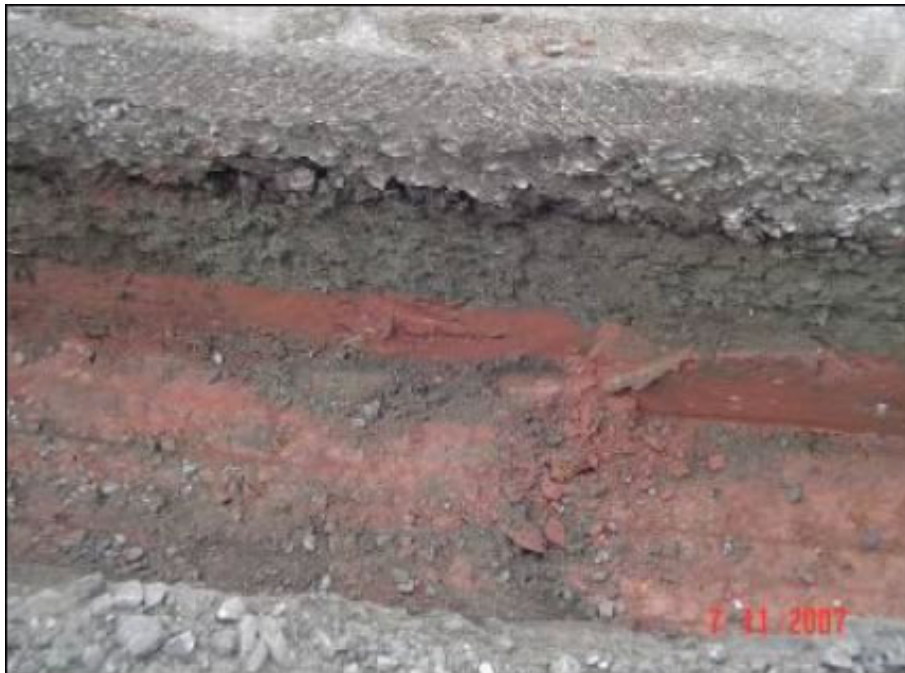
Figura 4 - Imagem do perfil do solo da vala de drenagem.
