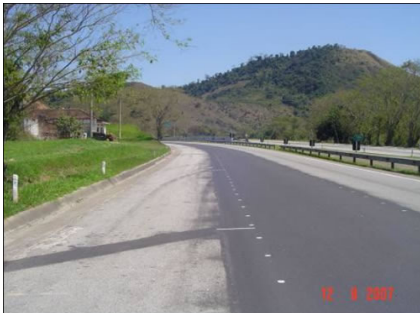
Figura 10: Imagem final do trecho pronto já executado com detalhe do dreno transversal.
