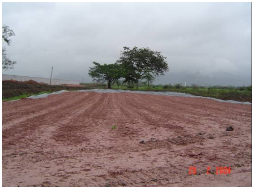
FOTO 6 Lançamento e espalhamento do material granular para execução do aterro.
