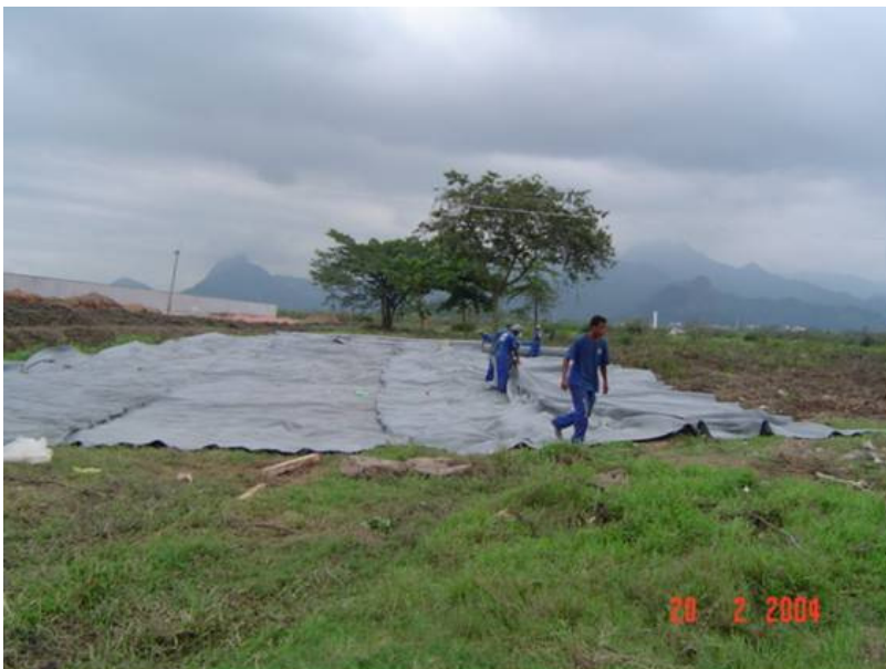
FOTO 4 Instalação do geotêxtil Bidim RT-31.
