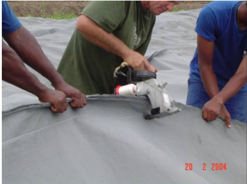
FOTO 3 Costura do geotêxtil Bidim RT-31.
