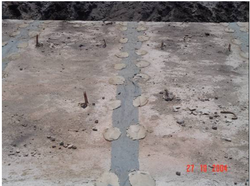
FOTO 7 Detalhe da junta.
