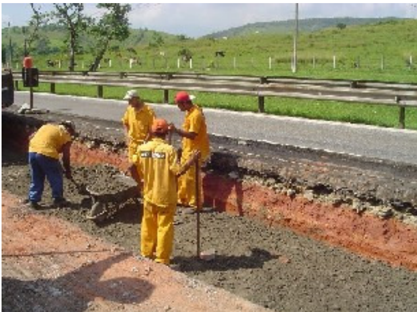
FOTO 4 Execução da primeira camada de BGS.
