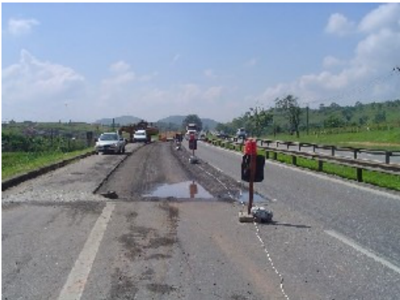
FOTO 8 Execução da camada de PMQ compactada.
