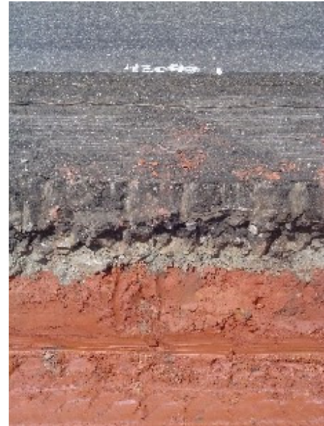
FOTO 7 Corte longitudinal do pavimento.
