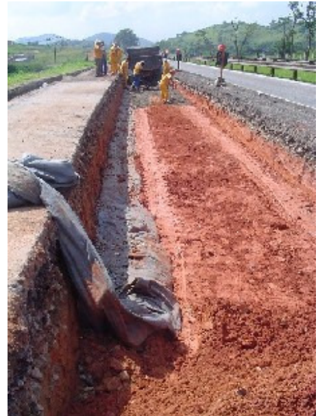
FOTO 3 Detalhe do dreno lateral a pista.
