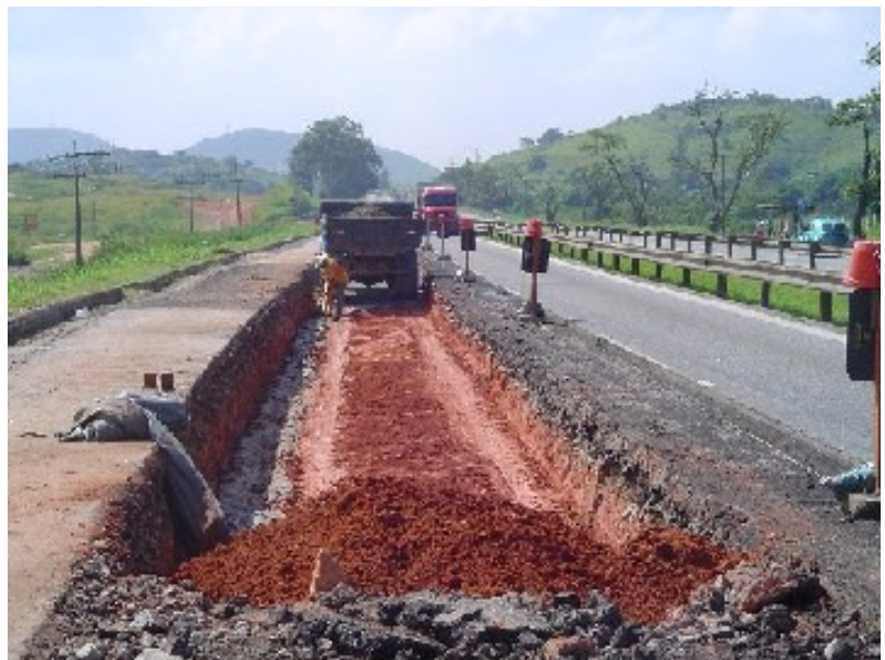
FOTO 2 Execução do dreno profundo.
