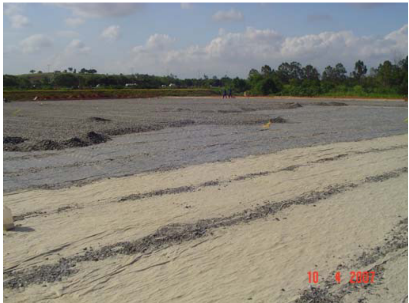
FOTO 10 Lançamento do lençol geotêxtil Bidim sobre o colchão de brita.
