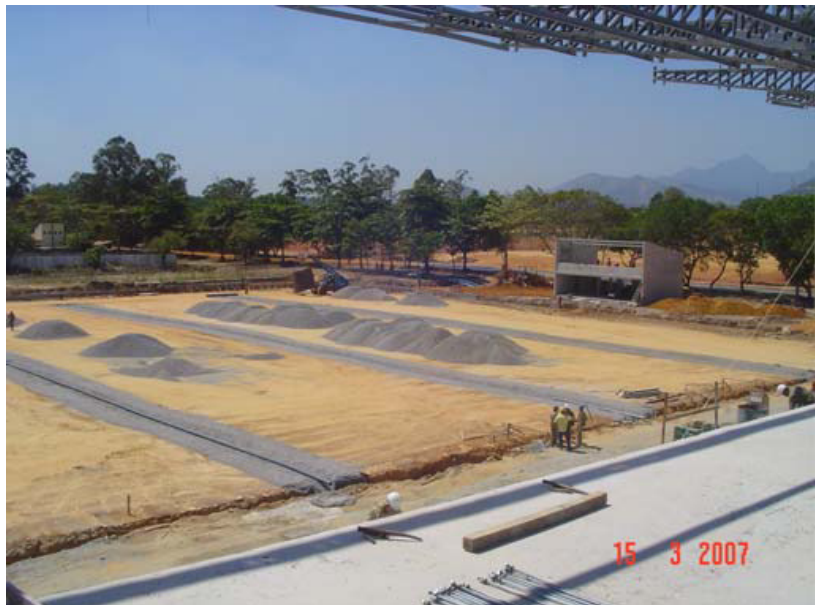
FOTO 6 Detalhes das trincheiras drenantes dispostas em paralelo.
