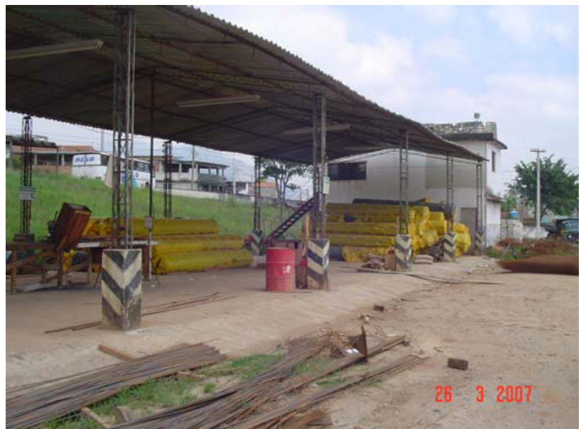
FOTO 2 Estoque de geotêxtil Bidim RT-10 e Bidim RT-16 na obra.
